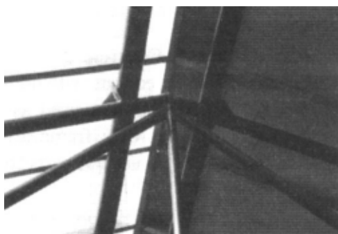
Charpente de base en tuyaux métalliques combinés avec des chevrons et lattes en bois.
