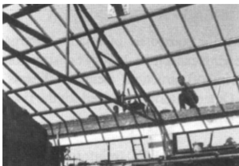
Charpente de base en tuyaux métalliques combinés avec des chevrons et lattes en bois.
